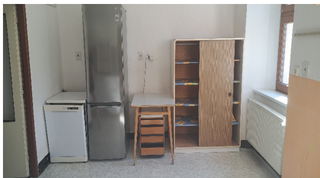
Školní kuchyně před rekonstrukcí
